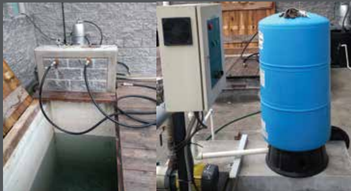
INSTALACIÓN HIDRÁULICA PARA PRUEBA DE PRESIÓN
