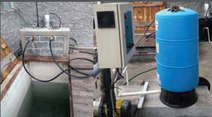
INSTALACIÓN HIDRÁULICA PARA PRUEBA DE PRESIÓN
